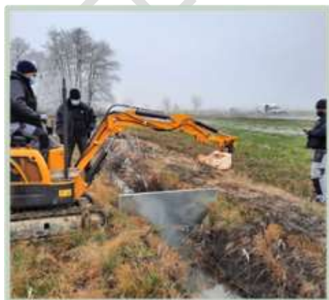
Slika 49: Nameščanje mikrozapornice v terciarni jarek z mini rovokopačem (foto: Boštjan Mali)
